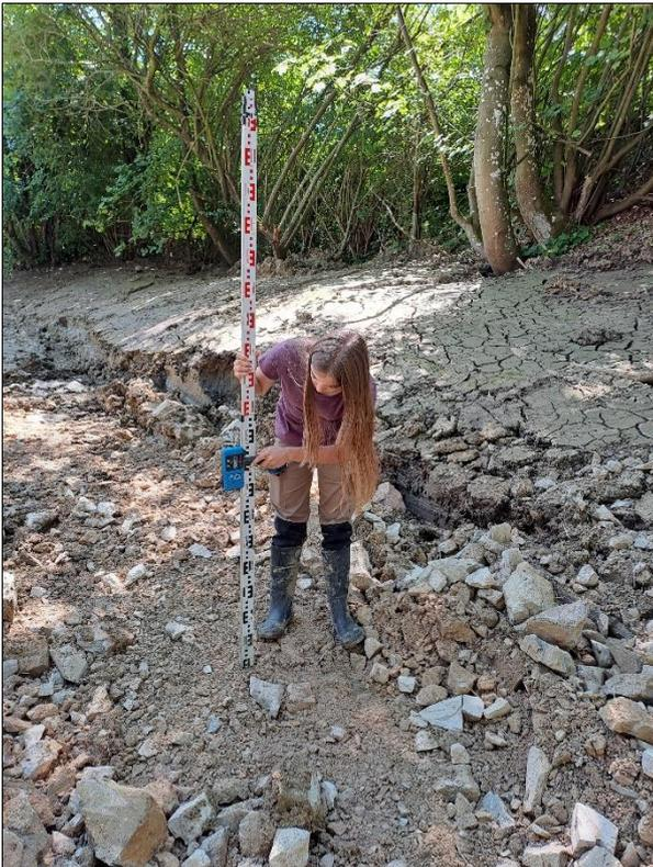
Pour le curage du cours d'eau le technicien rivière de la CUA ainsi que le technicien de la Fédération et une stagiaire ont réalisés des relevés de niveaux d'eau tout les 10 m pour ne pas perdre la pente qui est de 0,1 %.
