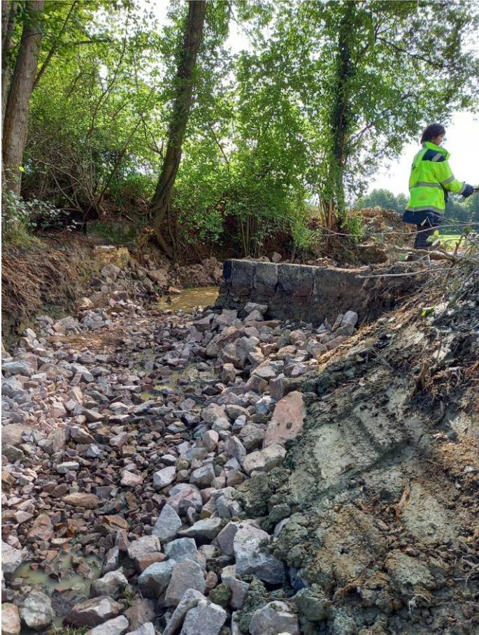
Fin de la recharge de fond en 0/300 mm puis mise en place d'une couche de finition en 0/63 mm.
