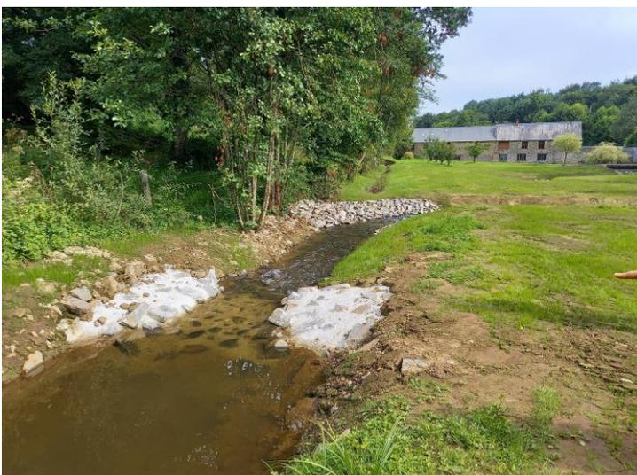
Le retalutage des berges au niveau de cette prise d'eau de façon à masquer les enrochements ;
