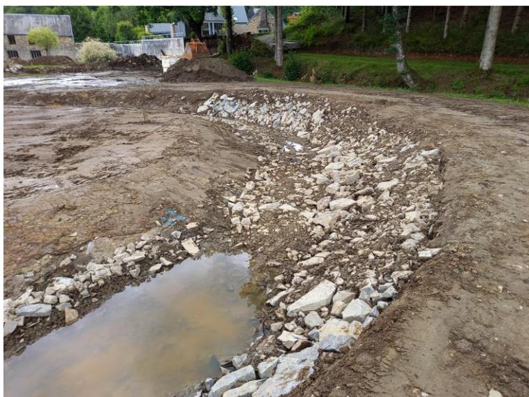
Les blocs triés et provenant du déblai de la prairie ont été réutilisés dans le bras de contournement notamment pour conforter les berges dans les zones les plus sensibles à l'érosion (intrados des méandres). D'autres blocs ont été déposés dans le bras de contournement afin de créer des caches pour la faune piscicole.
