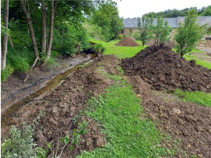
Le comblement du bief avec reprise des matériaux issus du déblai par couches de 0,30 m d'épaisseur jusqu'à la cote des berges du canal -0,5 m ;
