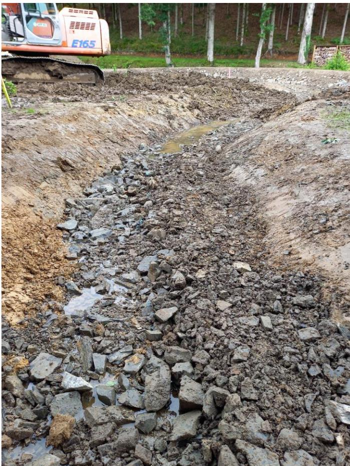
Des radiers ont été placés en amont et en aval du bras de contournement pour stabiliser le profil en long et éviter le risque d'érosion régressive. Le premier radier est placé en aval immédiat de la prise d'eau du bras de contournement. Le second radier est situé au niveau de la confluence entre le bras de contournement et le bras de décharge.
