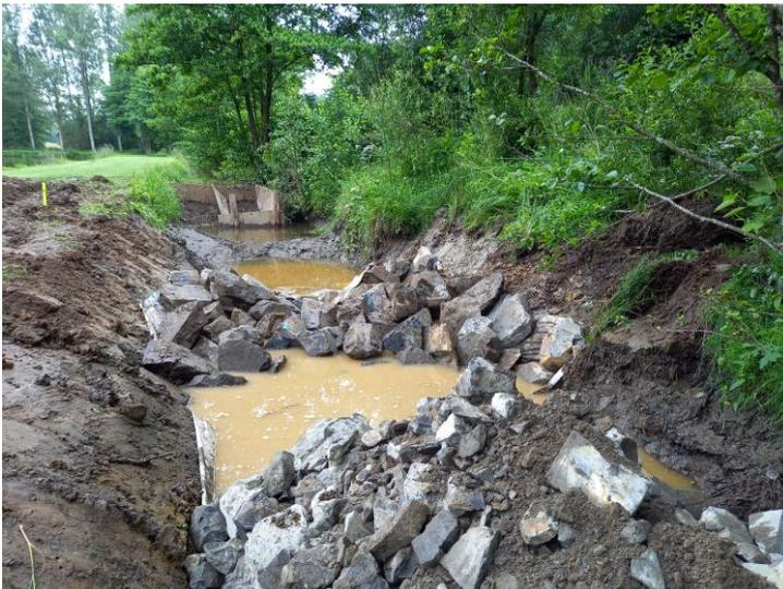
L'apport et la mise en place de blocs 300/400mm ancrés en fondation au droit des bêtes d'ancrage et bloqués entre eux (liaisonnés) tels que définis sur les plans et coupes. L'ouvrage est bien ancré en berge ;
