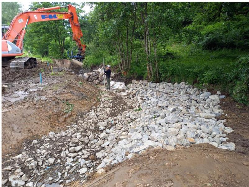
Le terrassement en remblais par couches de 0.30 m d'épaisseur des nouvelles berges de l'ouvrage de contournement (3H/2V) tel que défini sur les plans ;
