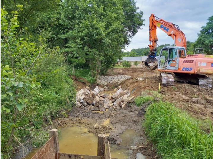
La réalisation de bêche d'ancrage jusqu'à -30 cm en dessous de la cote du fond dur.
